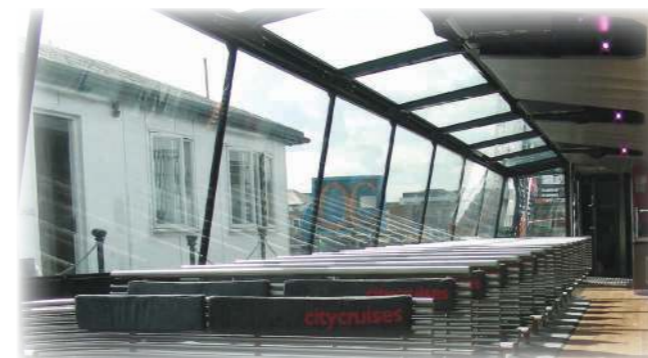
Innenansicht der minimalistischen Rahmenkonstruktion
